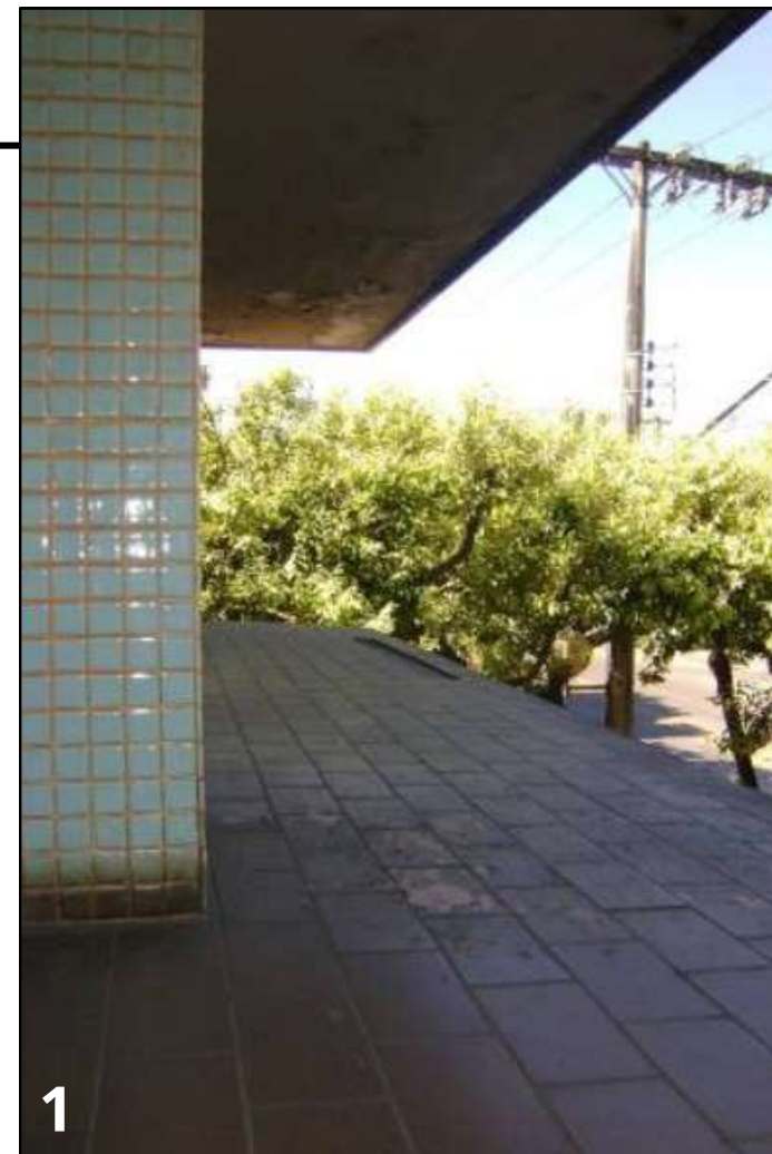
1 detalhe de parte do brise frontal. revestimento superior de cerâmica, com sujidades e partes quebradas ou soltas, necessitando de reparos em alguns pontos fonte.: dossiê de tombamento
